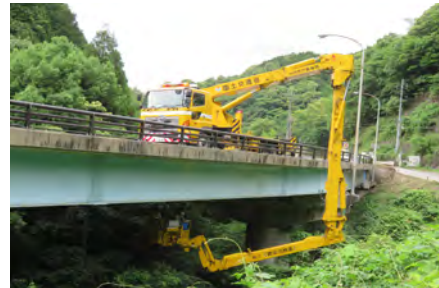
橋梁点検車による橋梁点検
