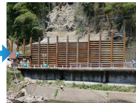
仮設落石防護構設計
