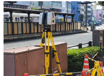
3D計測：地上レーザスキャナ (TLS: Terrestrial Laser Scanner)
