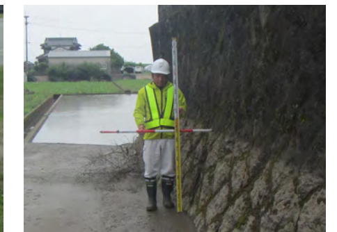
浸水状況調査
