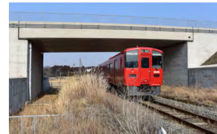
北側復旧ルート 赤水橋
