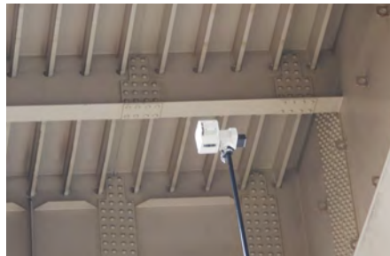
ロボットカメラによる橋梁点検
