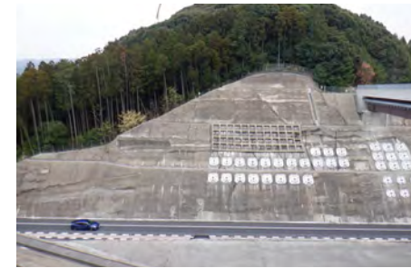
法面斜面地すべり対策
