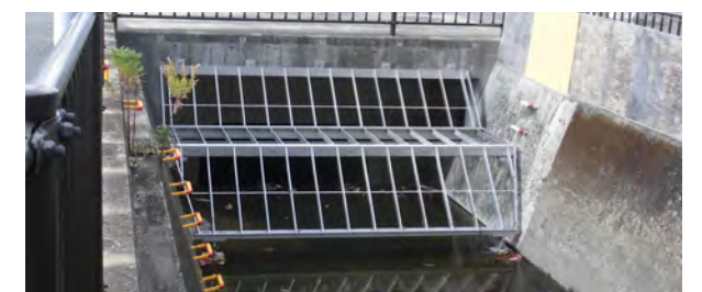
浸水対策 水路スクリーン改良
