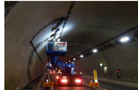
高所作業車によるトンネル点検
