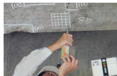
コンクリート強度調査
