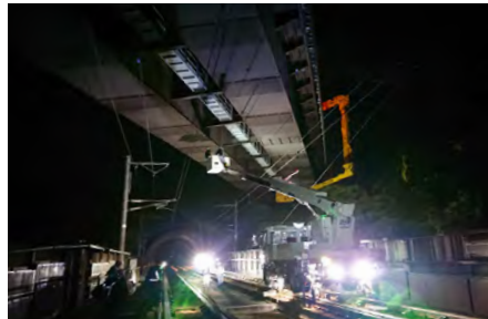
軌陸車、橋梁点検車による橋梁点検
