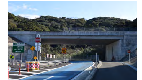
西九州自動車道 調川11号橋
